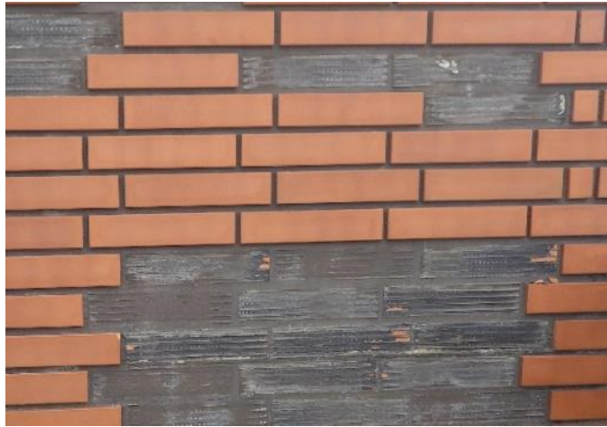
照片 2.2.3 磁磚陶片剝落案例
