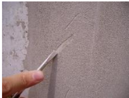
照片 4.4.1 檢查砂漿基底硬化狀態
