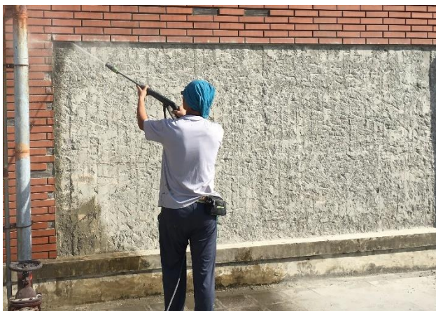
圖 4.3.3 使用高壓水柱清洗結構混凝土表面的作業
