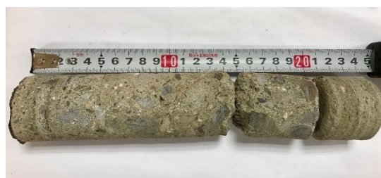
照片 2.3.4 經由岩心鑽孔取出的一部分外牆
