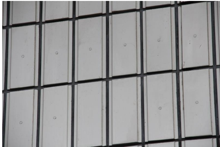
照片 3.4.1 採用附灌注孔之錨栓固定環氧樹脂灌注磁磚固定工法進行改修之磁磚外牆
