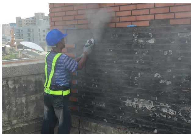
圖 4.3.1 操作研磨機去除砂漿黏著材的作業
