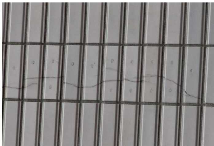
照片 3.4.2 採用附灌注孔之錨栓固定環氧樹脂灌注磁磚固定工法，改修同時發生浮凸的龜裂磁磚後的磁磚外牆
