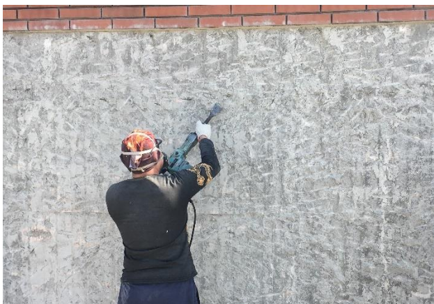
圖 4.3.2 使用電動整刀去除砂漿基底的作業
