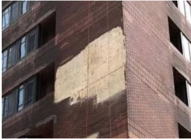
照片 2.2.5 從砂漿基底剝落的案例
