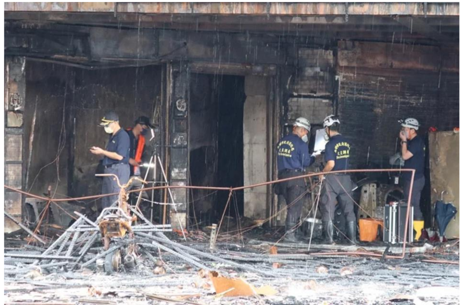
高雄城中城火警發生後，警、消勘查起火的房間。圖 / 本報資料照，記者林保光 / 攝影
