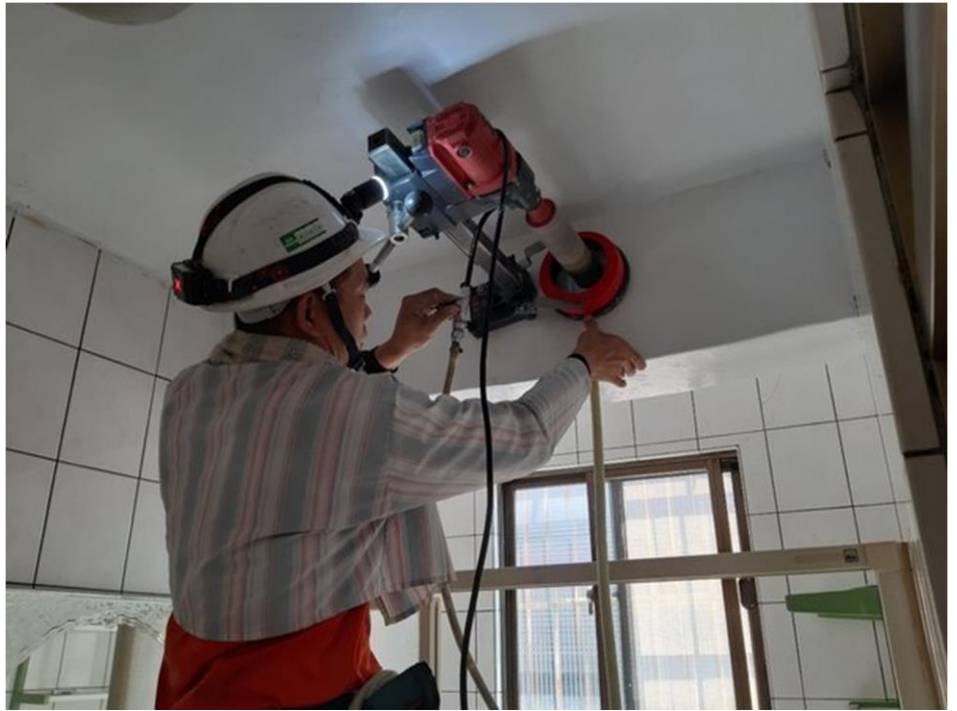
鑑定單位施作梁柱鑽心取樣鑑定作業。圖 / 新北市都市更新處提供
