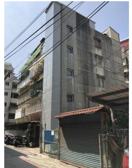
新北市政府提供都市更新整建維護補助，即日起受理民眾申請。圖為永和信義段增設電梯案。(圖由都更處提供)
