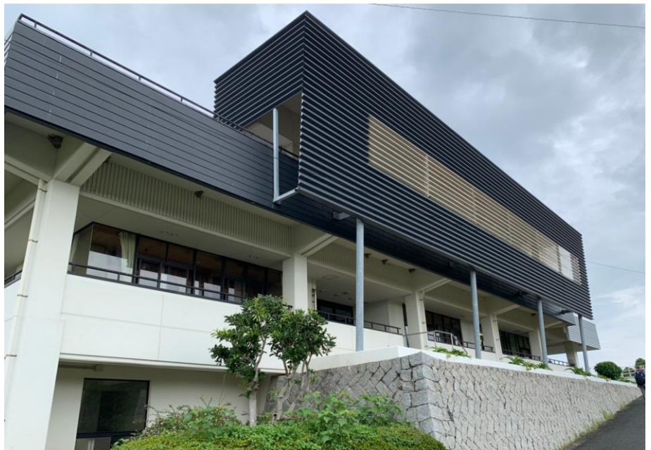
下關市豐北生涯學習中心 新設外牆以金屬、玻璃低汙染可回收之建材
