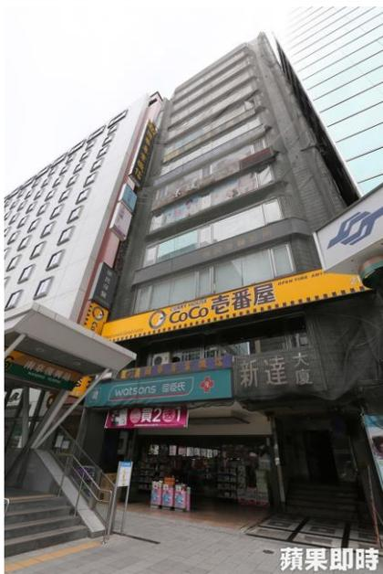
建築物外牆因磁磚剝落，修繕達不到共識，只能以鋁格網覆蓋。彭仁義攝
