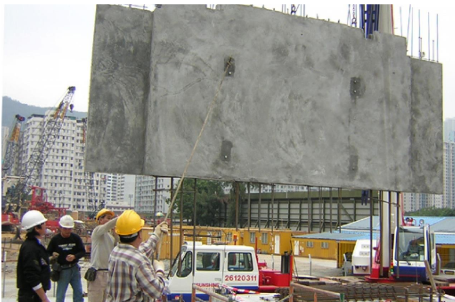
公屋在建屋工程增加使用預製混凝土組件和預製建築構件。
