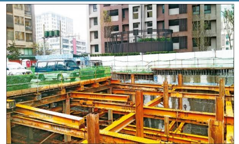
房屋結構與居住安全習習相關，老舊房屋健檢刻不容緩。
