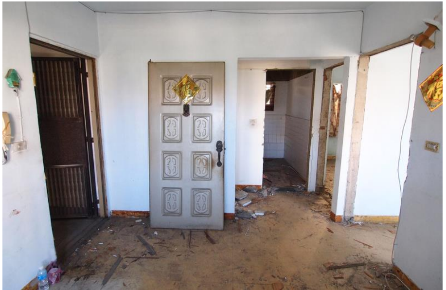
鳳山五甲台電宿舍修繕前照片。(高市都發局提供)
