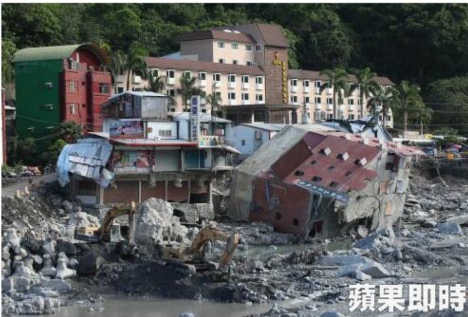
金帥飯店在 88 風災中倒塌。資料照片
