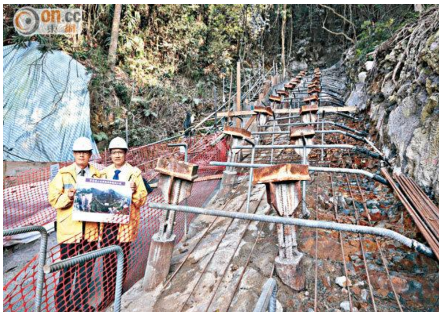
土木工程拓展署首次使用「引導牆」技術，當山泥傾瀉發生時可將大範圍的山泥集中引導至一個泥石壩。
