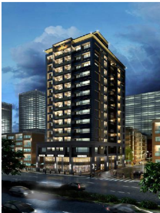
▲富也泰建設「府中參御苑」強調配備智慧冷暖空調。 建案專屬網站 http://tp.housetube.tw/16638
