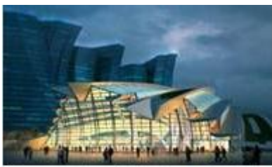
廣深港高速鐵路(香港段) 西九龍總站
